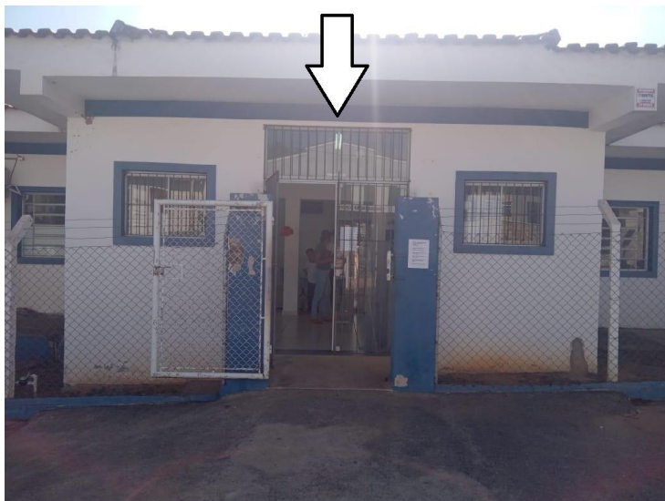
Foto 7 – Ilustração de local de instalação.
