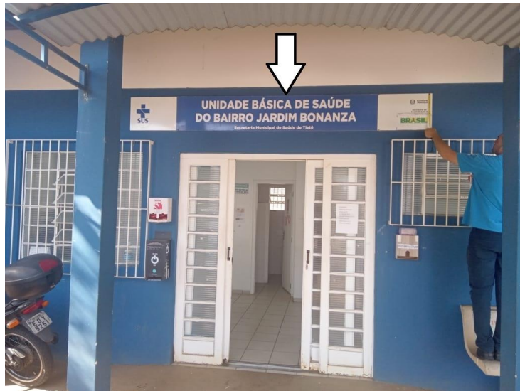
Foto 3 – Ilustração de local de instalação.
