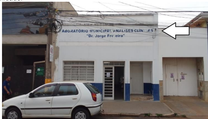
Foto 11 – Ilustração de local de instalação.
