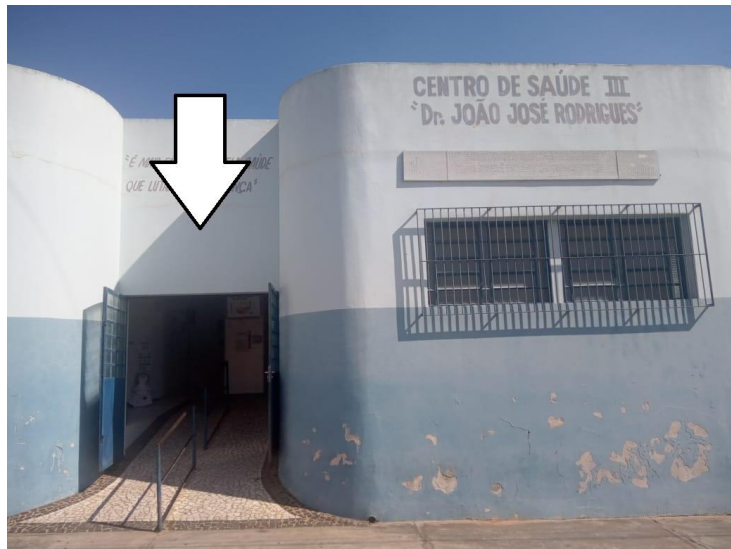
Foto 4 – Ilustração de local de instalação.
