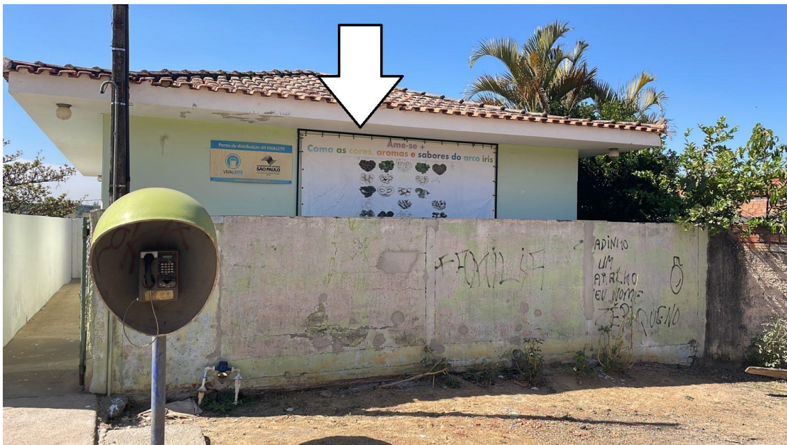
Foto 10 – Ilustração de local de instalação.
