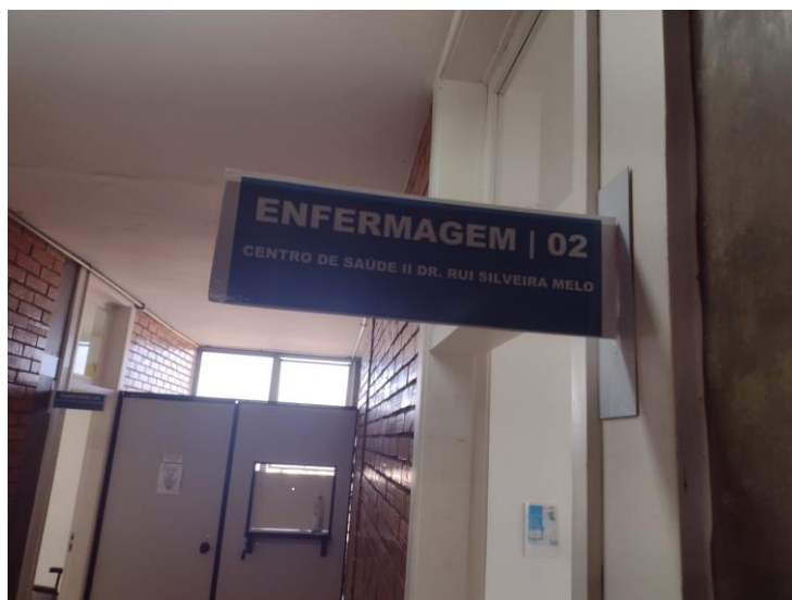
Foto 1 – Exemplo de fixação da placa lateral.
