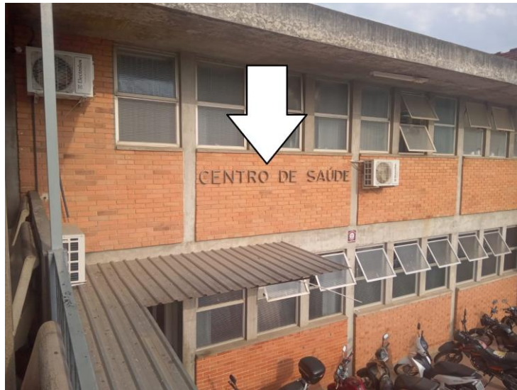
Foto 9 – Ilustração de local de instalação.
