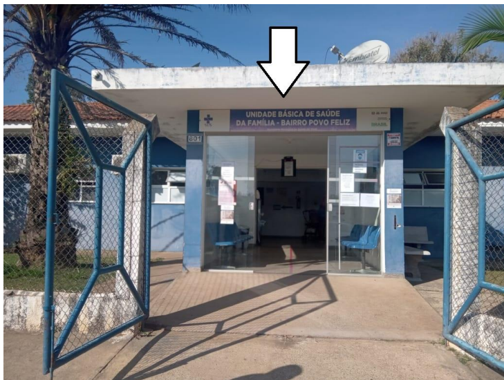
Foto 5 – Ilustração de local de instalação.
