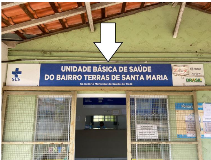
Foto 6 – Ilustração de local de instalação.
