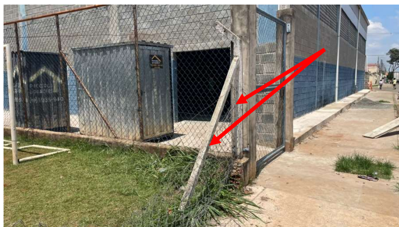
FOTO 2 - Vista dos mourão em concreto do alambrado a ser removido
