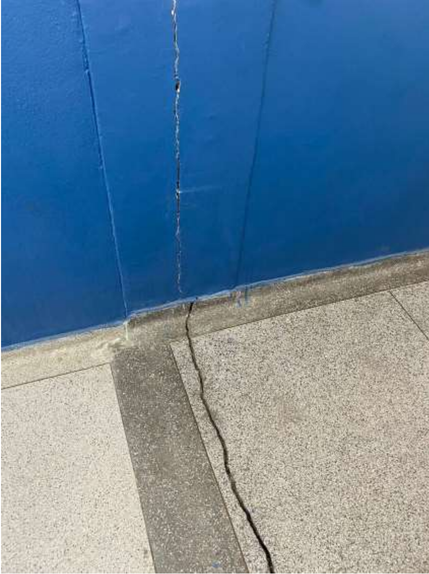
FOTO 2 - Vista do corredor interno do Bloco II
