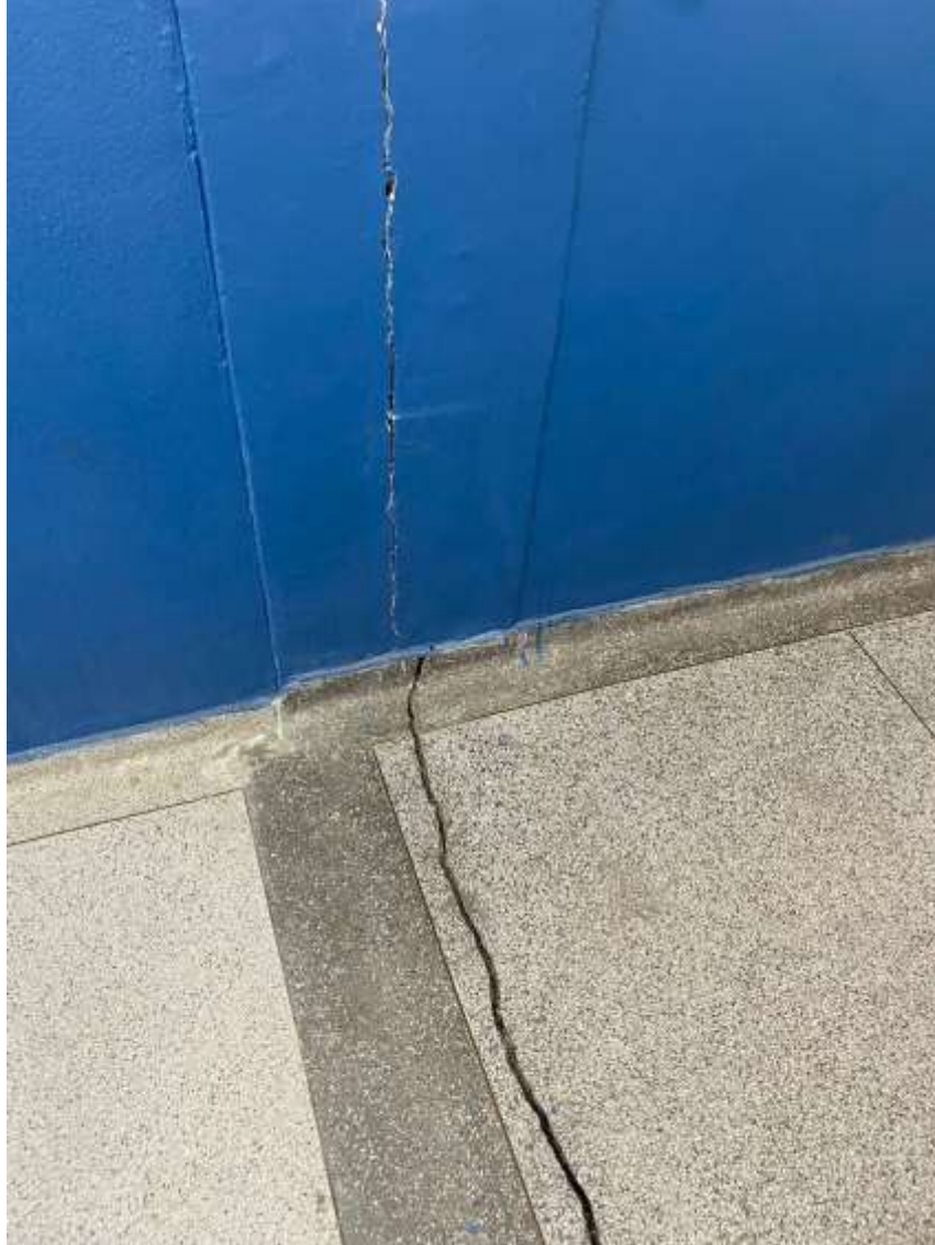
FOTO 2 - Vista do corredor interno do Bloco II
